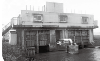
新堀川暗渠排砂場水機場
